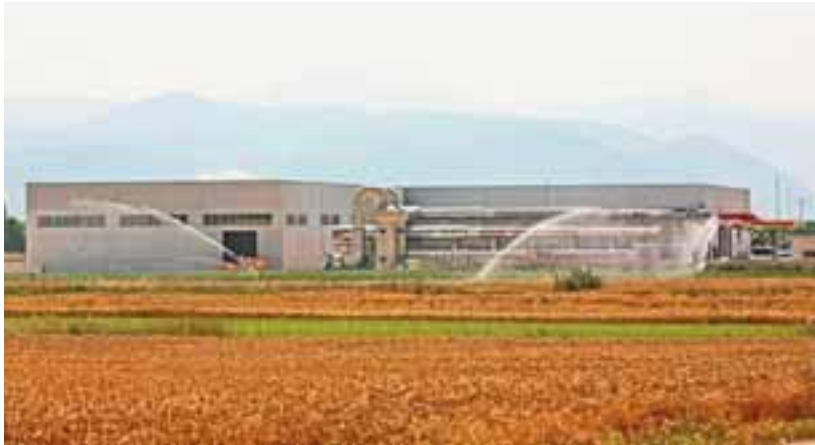
Impianto Aielli esterno
